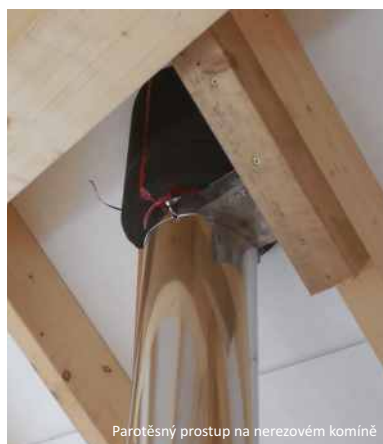
Svislý kouřovod s parotěsným průstupem
