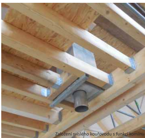
Založení svislého kouřovodu s funkcí komínu
