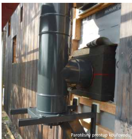
Parotěsný vstup kouřovodu
