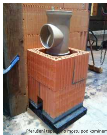
Přerušení tepelného mostu pod komínem
