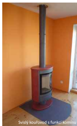
Svislý kouřovod s funkcí komínu
