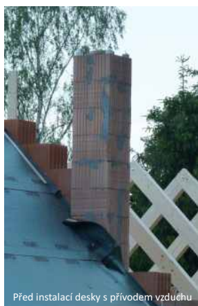
Před instalací desky s přívodem vzduchu
