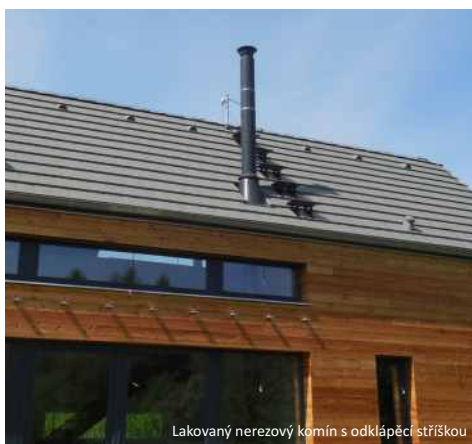
Lakovaný nerezový komín s odklápací stříškou
