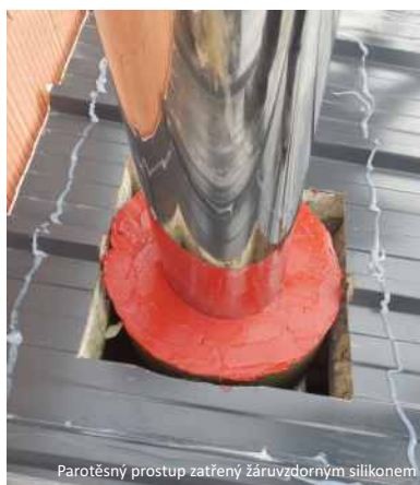
Svislý kouřovod s parotěsným průstupem
