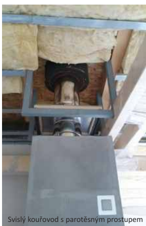
Parotěsný průstup na nerezovém komíně
