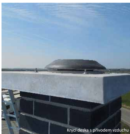
Krycí deska s přívodem vzduchu
