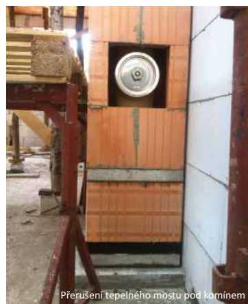
Přerušení tepelného mostu pod komínem
