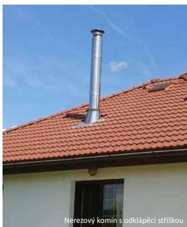
Nerezový komín s odklápací stříškou
