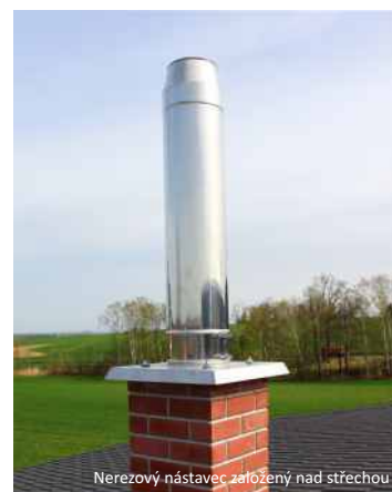
Nerezový nástavec založený pod střechou
