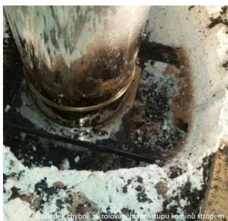
Následek chybně izolovaného prostupu komínů stropem
