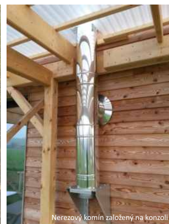
Nerezový komín založený na konzoli
