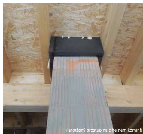
Parotěsný průstup zatřený žárovzdorným silikonem
