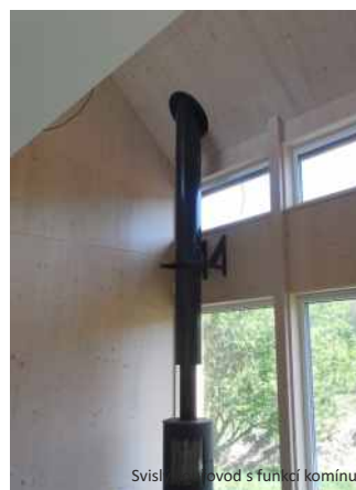
Svislý kouřovod s funkcí komínu
