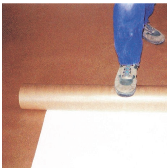
Obr.2 Položení separační vrstvy.
