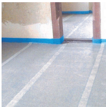
Obr.3 Položení maxit floor 4945 systémové tkaniny.
