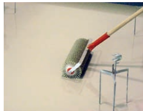
Odvzdušnění a rozprostření směsi ježatým válečkem .
