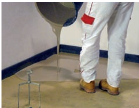
Nanesení stěrky v požadované konzistenci.
