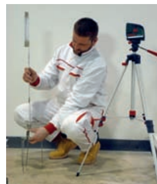
Zaměření nivelety a stanovení výšky podlahové konstrukce.
