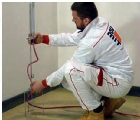
Zaměření nivelety a stanovení výšky podlahové konstrukce.
