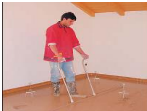
Stanovení výšky hladiny úrovnovými měrkami
