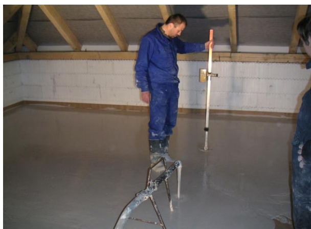
Stanovení výšky hladiny litého potěru laserem
