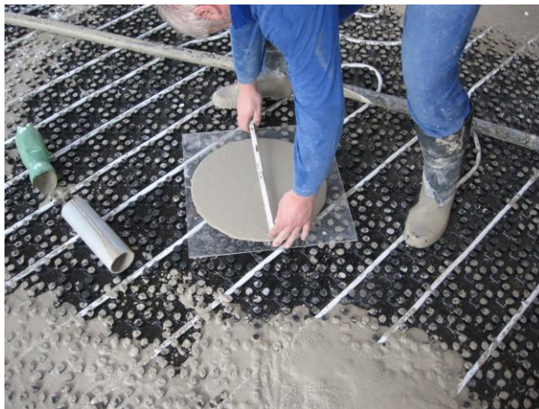
Měření průměru rozlitého potěru
