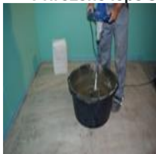
míchání vrtulovým míchadlem
