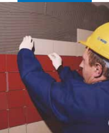
Lepení keramického obkladu shora dolů
