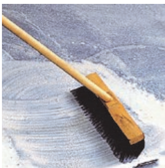
Obr.2 Podklad zpenetrovat předepsanou penetrací.
