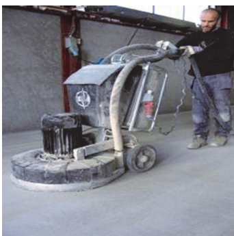
Obr.1 Podklad připravit předepsaným způsobem.
