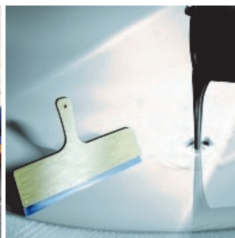
Obr.4 Materiál vylít na podklad a zpracovat vhodným nářadím.
