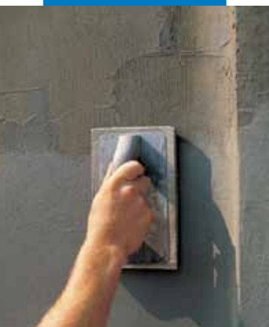
Vyhlazení houbovým hladítkem
