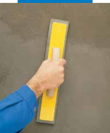
Vyhlazení houbovým hladítkem
