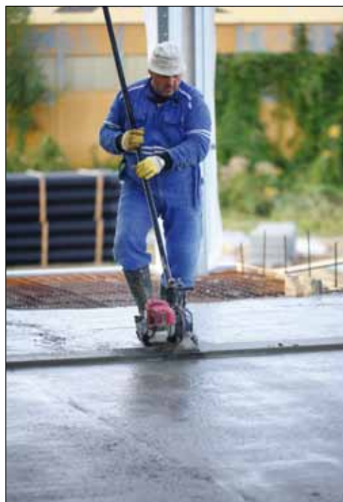
zpracování betonové směsi vibrační latí
