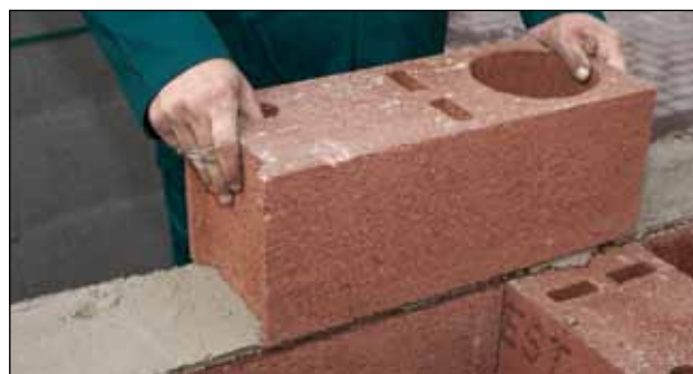
provázání vnitřní a obvodové zdi (u vnějšího zateplení)
