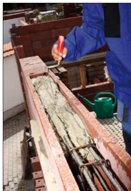
vybetonování vytvořeného překladu s složenou výztuží
