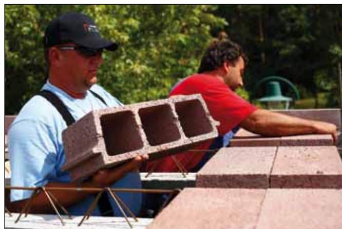
správné postupné kladení stropních vložek z jedné strany
