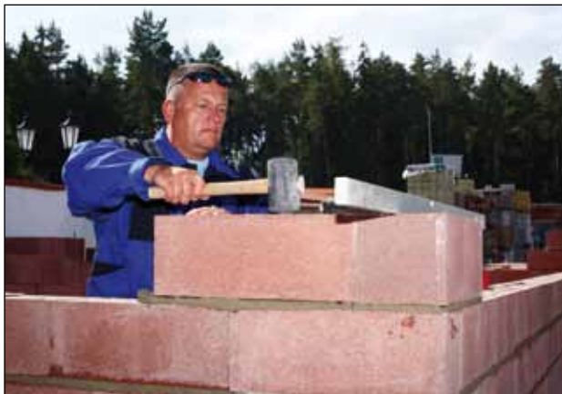
zajištění vodorovnosti poklepem gumovou palicí
