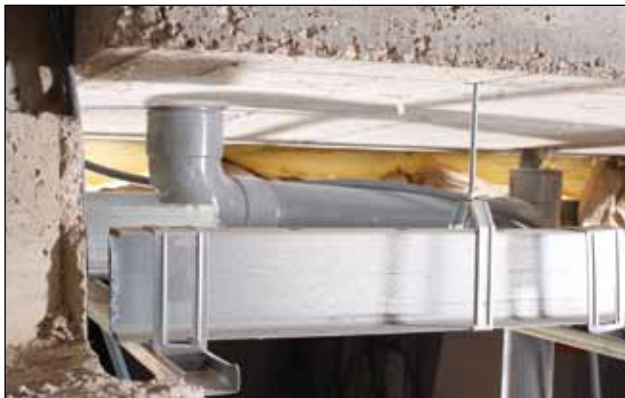
vedení odpadní roury skrz stropní konstrukci
