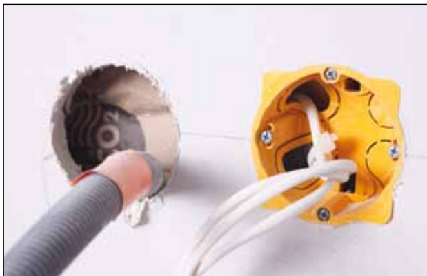
detail instalace zásuvky/vypínače
