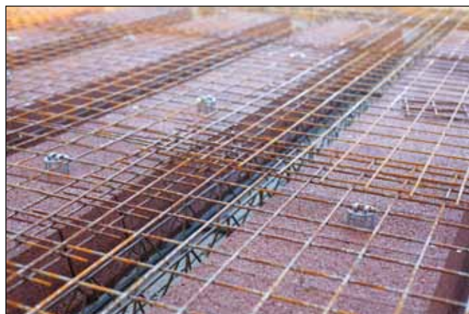
vložená KARI síť s distančními podložkami
