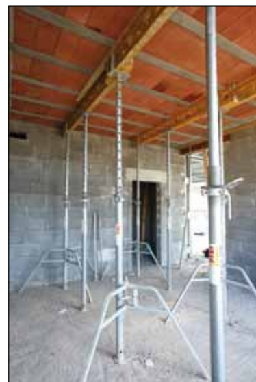
podepření stropních nosníků
