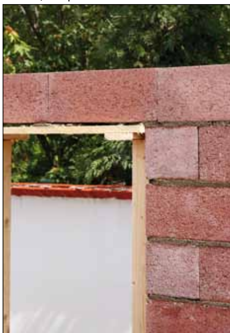
předem připravené bednění pro realizaci překladu
