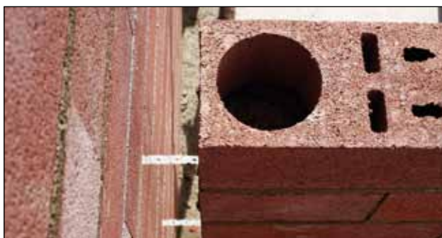
výstavba vnitřní zdi před montáží vnitřního zateplení na snímku vnitřní nosná zeď z tvárnice BEST – UNIKA 20
