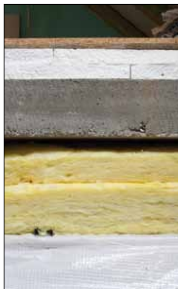
ukázka zateplení stropní konstrukce a podlahy
