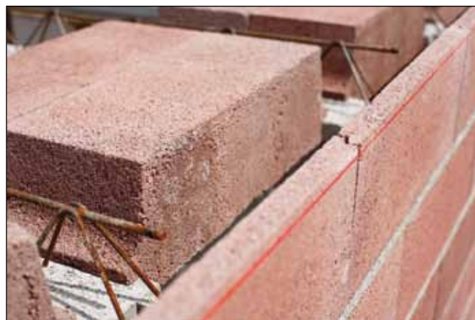
věnc tvořený polovinou tvárnice BEST – UNIKA věncová/překladová
