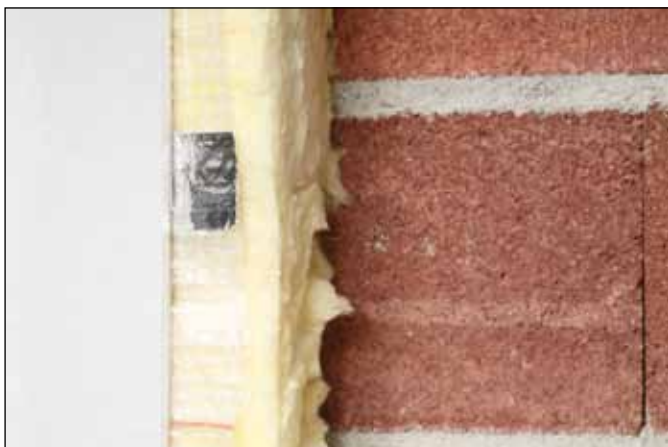
detail vnitřního zateplení stěn minerální vatou
