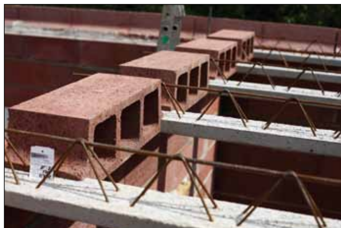
konstantní osová vzdálenost mezi nosníky je 600 mm
