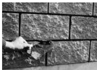
5.–6. Zdění a spárování probíhá v jedné operaci. Povrch spár se uzavře uhazením spárovacím hladítkem nebo upraveným dřevěným kolíkem.
