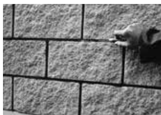
5.–6. Zdění a spárování probíhá v jedné operaci. Povrch spár se uzavře uhazením spárovacím hladítkem nebo upraveným dřevěným kolíkem.
