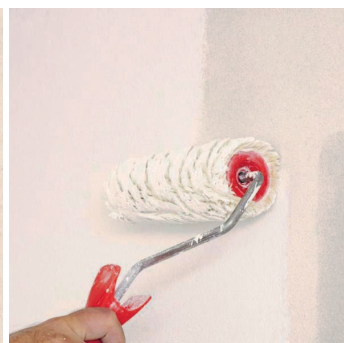
Obr.4 Provedení nátěru barvou.
