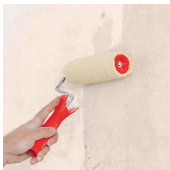
Obr.3 Provedení penetračního nátěru.
