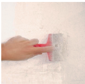
Obr.2 Odstranění nesoudržných vrstev.
