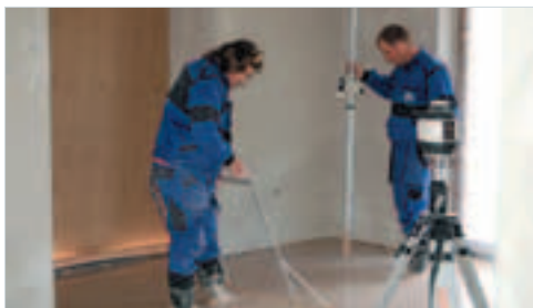
Základem úspěšného výsledku je i přesné zaměření výšky potěru
