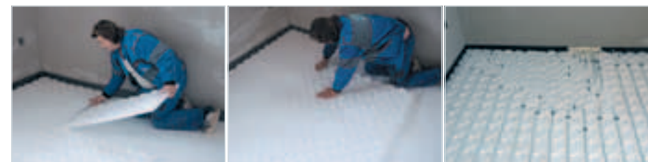
Pokládka systémových desek pro podlahové topení
