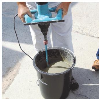
Obr.3 Namíchání materiálu pomocí míchadla nebo m-tec duo-mixu nebo za silu pomocí m-tec SMP PU.
