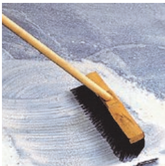
Obr.2 Podklad zpenetrovat předepsanou penetrací.
