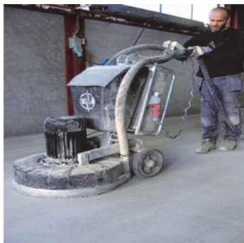
Obr.1 Podklad připravit předepsaným způsobem.
