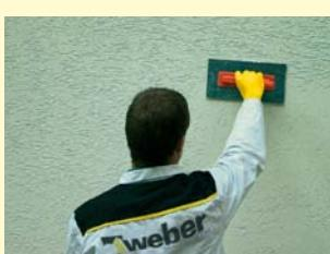
Struktura se vytváří plastovým hladítkem ihned po nanesení. Tahy hladítkem musí být stejnomořně v celé ploše, zvláště v místech koutů, úrovni podlážek lešení apod.
