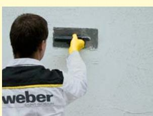
Omítka se nanáší na podklad nerezovým hladítkem na sílu vrstvy danou velikostí zrna. Omítku je třeba napojovat ještě před jejím zavádnutím takzvaně „do živého“. Ucelené plochy provádět bez přerušení.
