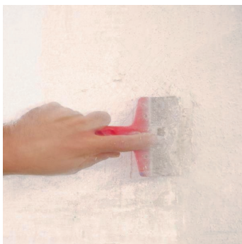
Obr.2 Odstranění nesoudržných vrstev.
