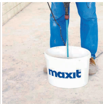
Obr.3 Promíchání penetračního nátěru.
