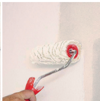
Obr.4 Provedení penetračního nátěru v 1 vrstvě.
