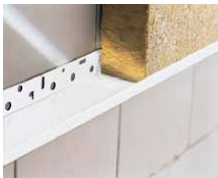
založení zateplovacího systému s tepelným izolantem z minerální vlny (lamely s kolmým vlákny) lepené na nosnou konstrukci maltou quick-mix RKS
