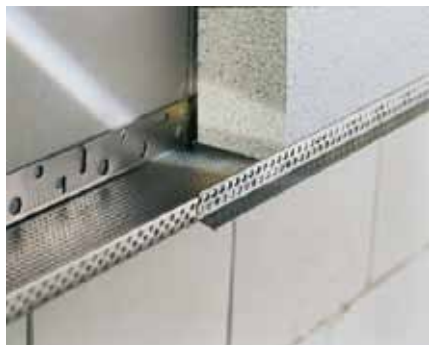
založení zateplovacího systému s tepelným izolantem z EPS lepeným na nosnou konstrukci maltou quick-mix RKS
