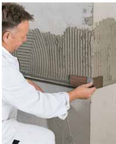
založení rohového cihlového pásku
