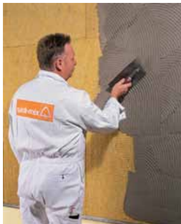
nanášení stěrkovací hmoty malty quick-mix RKS na tepelný izolant pro montáž pancéřové armovací skelné tkaniny
