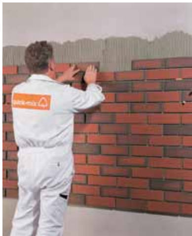
lepení cihlového pásku v ploše
