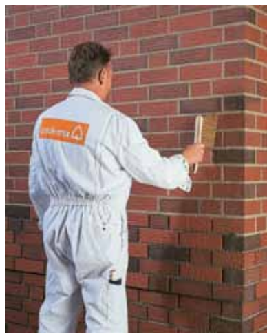
konečné očištění vyspárované plochy opatrným ometením smetáčkem
