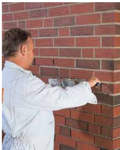
spárování obkladu spárovací maltou quick-mix FM
