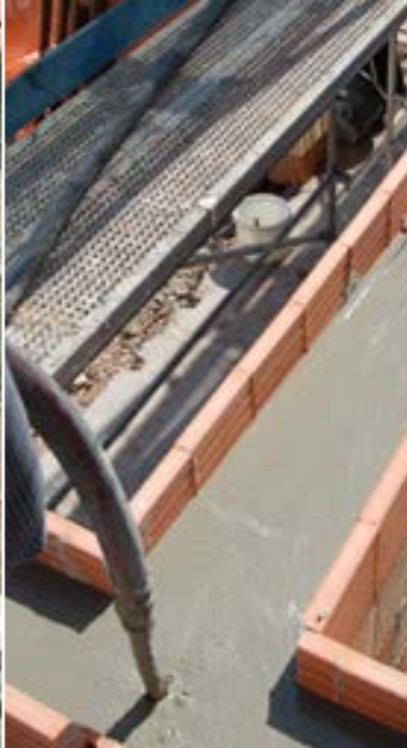
Lití věnce čerpatelným betonem maxit ton 908 FB
