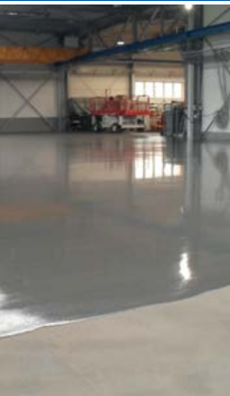
Liťí polymercementové stěrky maxit floor 4610
