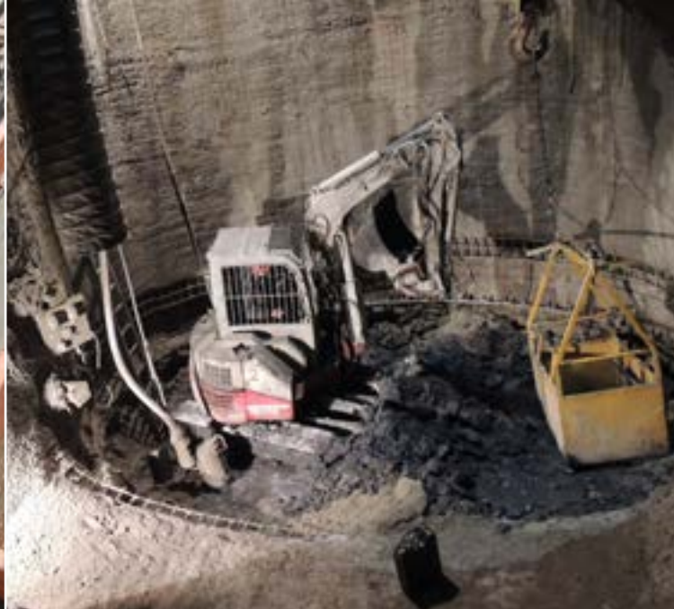
Bezbariérový vstup stanice metra Anděl, stříkaný beton maxit ton SB 80 B
