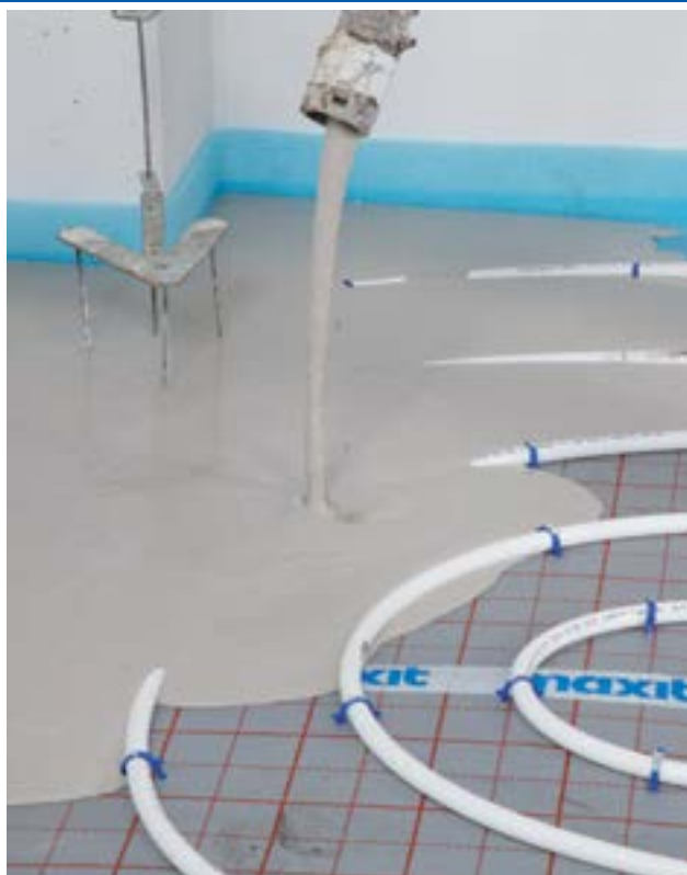
Liťí samonivelačního potěru maxit plan 490
