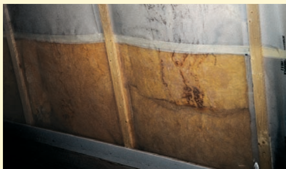
Poškození způsobené zabudováním vlhkého dřeva
