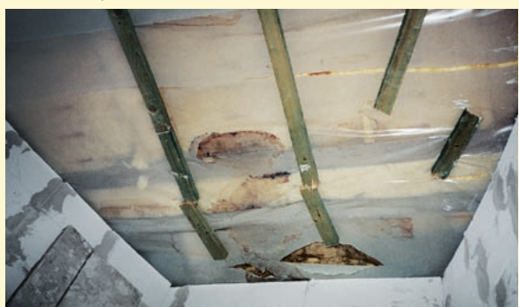
Poškození způsobené zkondenzovanou vodou
