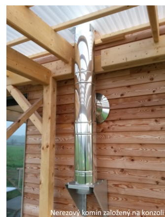
Nerezový komín založený na konzoli
