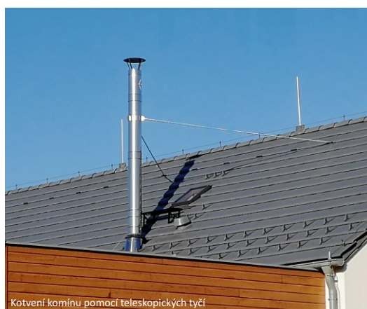
Kotvení komínu pomocí teleskopických tyčí
