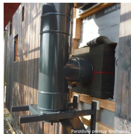
Parotěsný vstup kouřovodu
