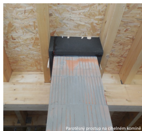
Parotěsný vstup na cihelném komíně
