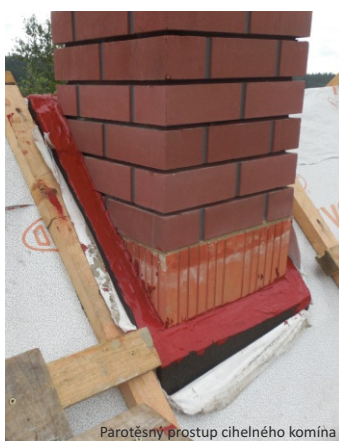
Parotěsný vstup cihelného komína
