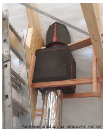
Parotěsné prostupy na nerezovém komíně
