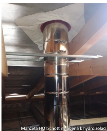
Manžeta HOTSchott naplněná k hydroizolaci
