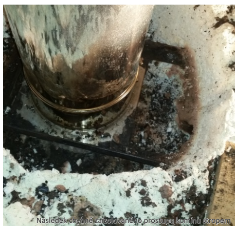
Následek chybné izolace prostupu komínu stropem
