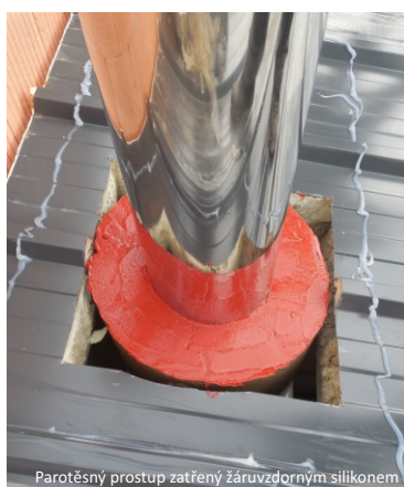
Parotěsný vstup zatřený žáruvzdorným silikonem
