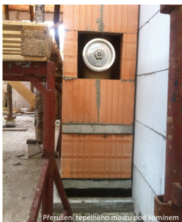
Přerušení tepelného mostu pod komínem
