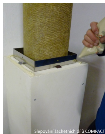
Slepování šachetních dílů COMPACT
