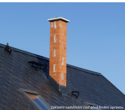
Základní nadstřešní část před finální úpravou
