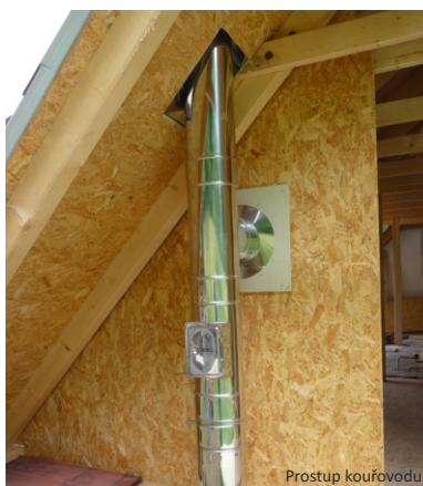
Prostup kouřovodu
