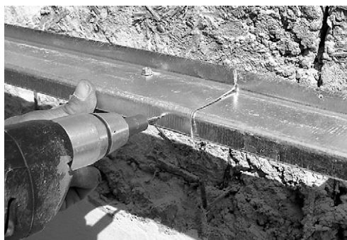
Napojení profilů Z50, velikost přesahu je 100 mm.
