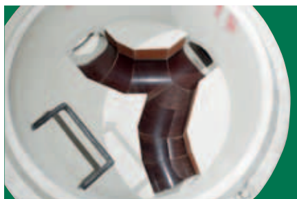
šachtové dno v provedení žlab – kamenina nástupnice – beton
