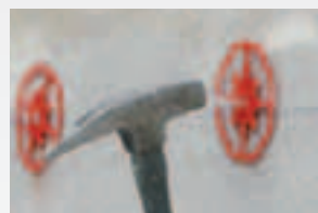
Baumit StarTrack Red se vsadí do vyvrtaného otvoru a upevní se zatlučením plastového trnu.
