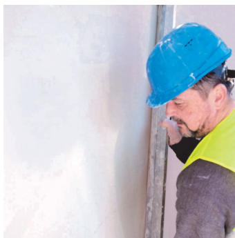
Obr.3 Po zatuhnutí stržení povrchu "v-latí" a odvodu stržením kolmo postavenou fasádní špachtlí.
