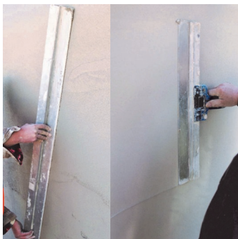
Obr.2 Urovnání povrchu "h-latí" a fasádní špachtlí.
