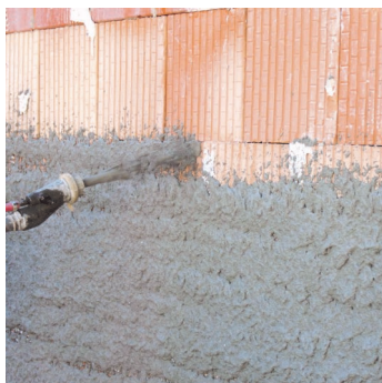
Obr.1 Nástřik omítky pomocí omítačky.
