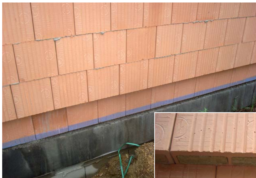
Ukázka použití soklových cihel v praxi - kombinace Porotherm 38 S Profi s cihlami Porotherm 44 T Profi plněnými minerální vatou
