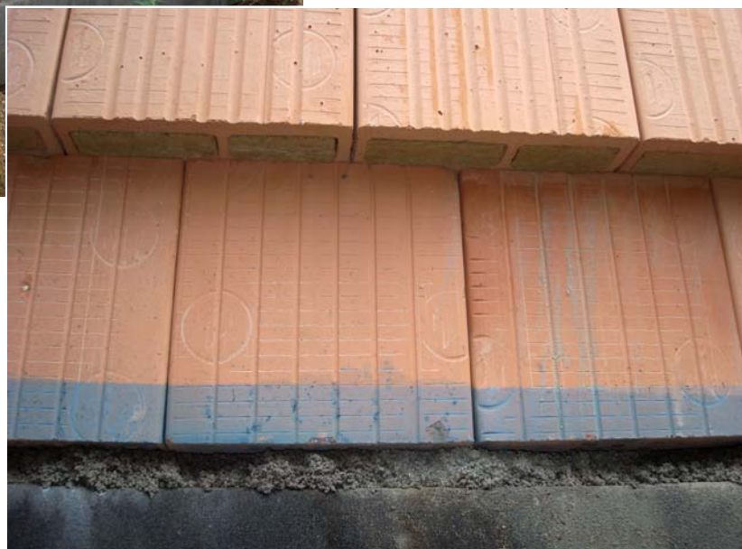
Ukázka použití soklových cihel v praxi - kombinace Porotherm 38 S Profi s cihlami Porotherm 44 T Profi plněnými minerální vatou
