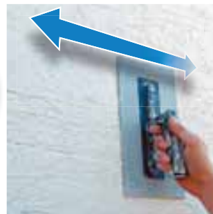
Vytváření rýhované struktury
