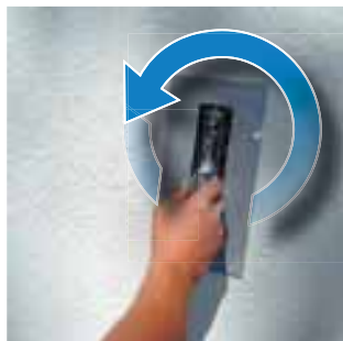
Vytváření zatírané struktury
