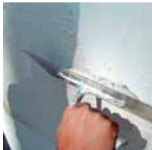
Nanášení zatírané a rýhované omítky
