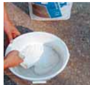
Rozmíchání minerální omítky s předepsaným množstvím vody
